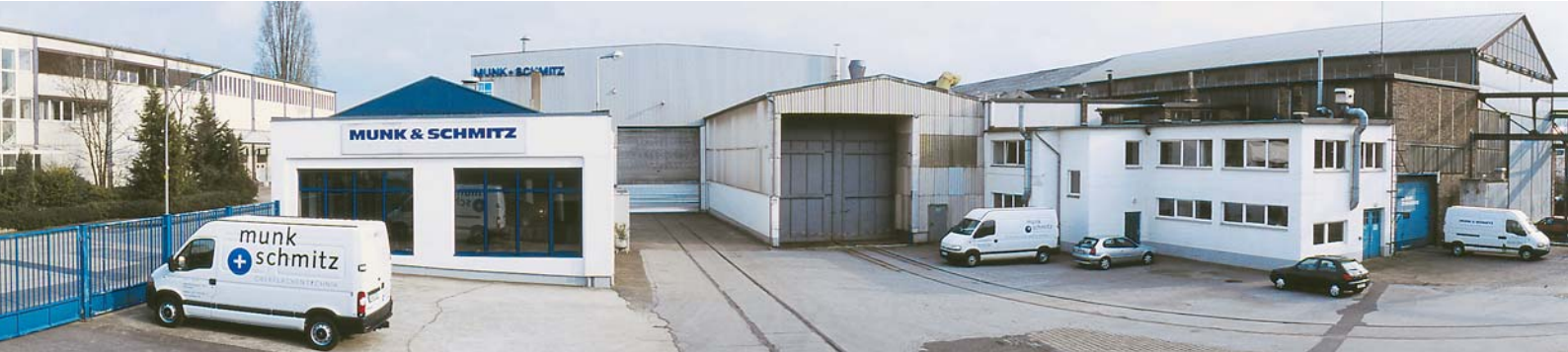
Ansicht der Produktions- und Entwicklungsanlagen von Munk + Schmitz
